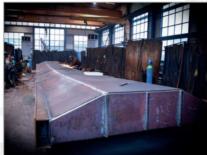
Bild 3 - Herstellung Rad- & Fussgängerpasserelle - Horgen
