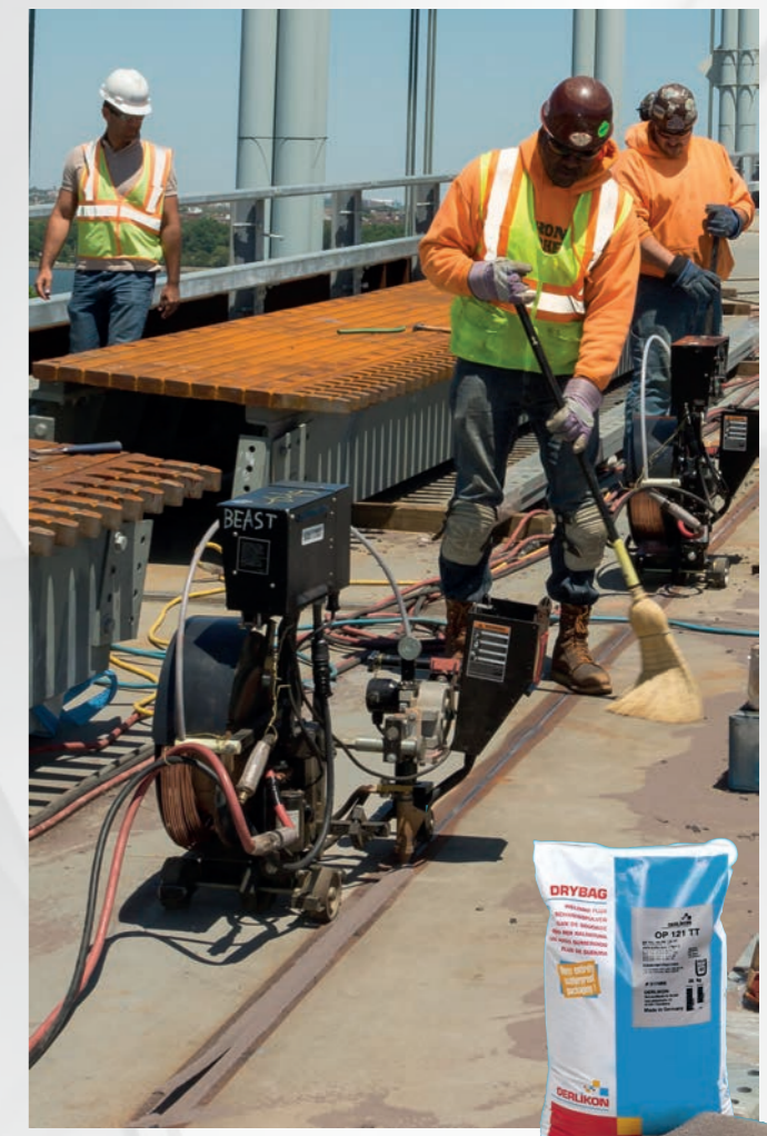
Das Bild zeigt den „selbststeuernden Traktor“ auf einer Schiene. Lincoln UP-Schweißen auf der Verrazano Brücke. Lincoln Flextec 500 mit LT-7 Traktor.
