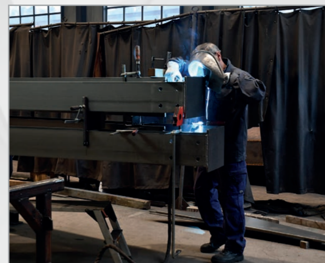
Bild 4 - Fachwerke Neubau Eberhard Recycling
