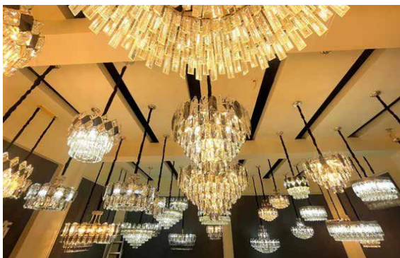
Apparecchi di illuminazione
